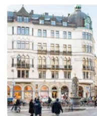
Pumpstocken 10 Byggår: 1865 Uthyrbar yta: 12 451 kvm
